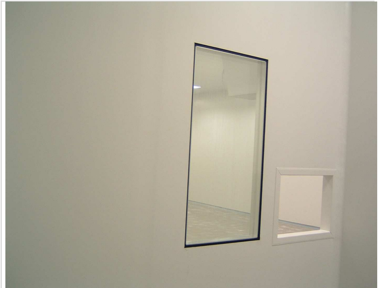
Technical Window su Thermodular EVOlution in resina con foro a pannello realizzato in cantiere con impiego di pantografo
